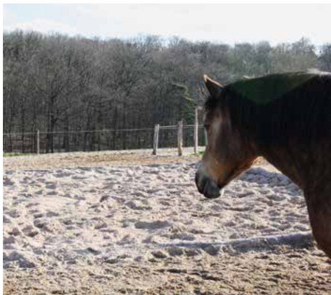
Wälzen können sich die Pferde auf dem Rappenhof sogar mit Aussicht und gut befestigt, ohne Matsch dank der Arbeit von SKM Bau.
