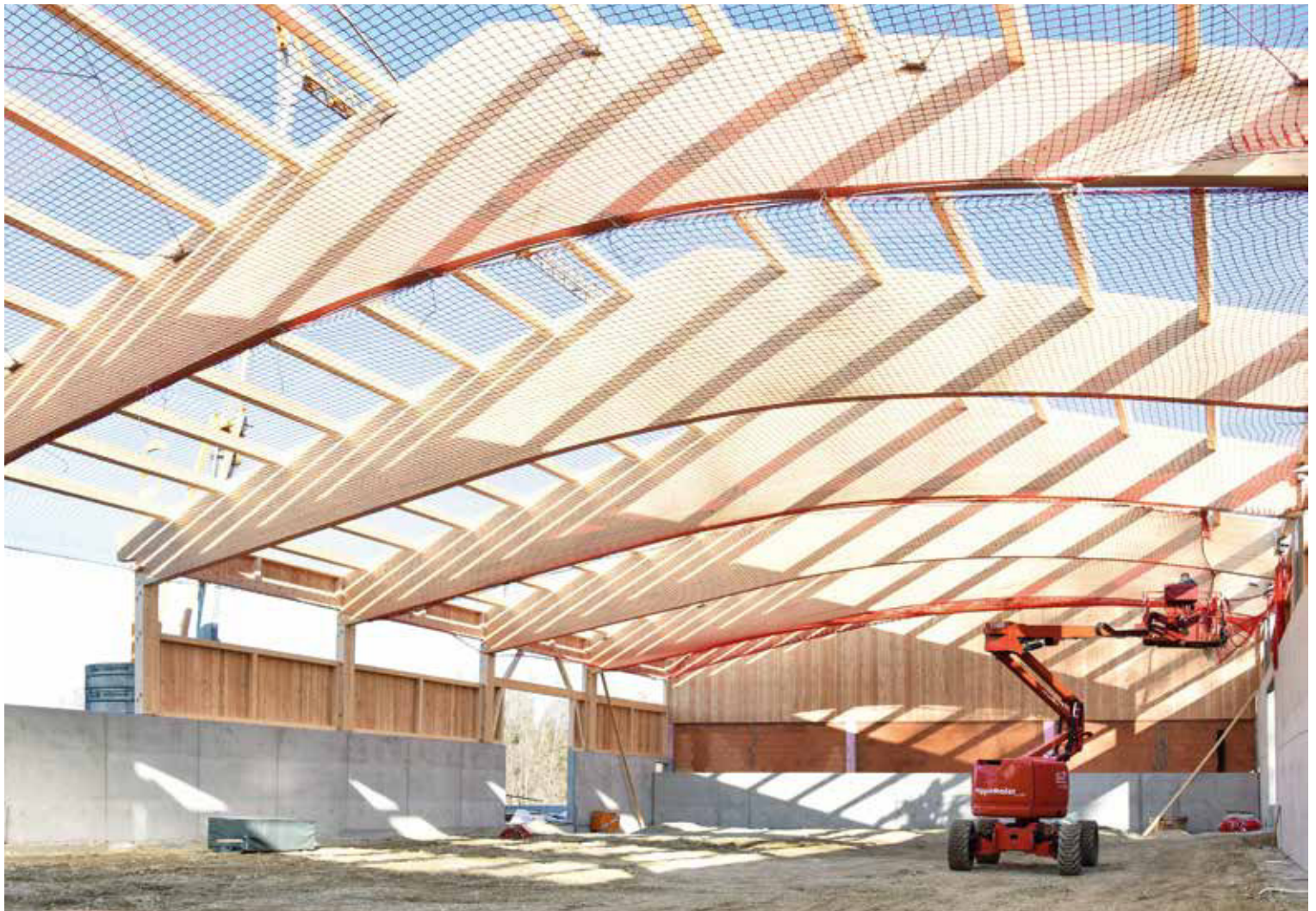
oben: Lochbleche sorgen für Luftaustausch und ausreichend Lichteinfall, gleichzeitig machen sie keine Geräusche. unten: Das Team montiert Bogenbinder und Pfetten.
